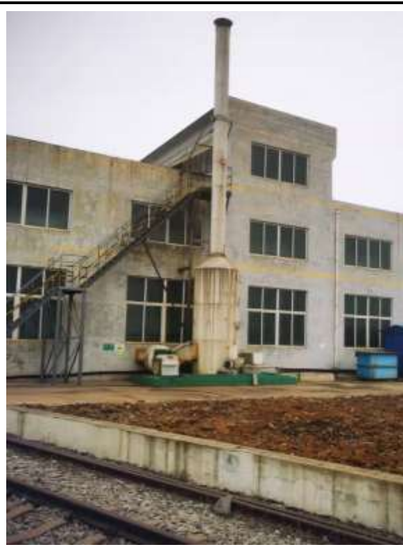
电镀废气排放口 (DA002)
